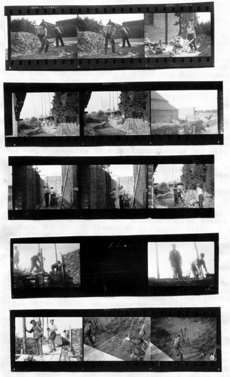
Arbeiten am Kirchbau Ende August 1950
